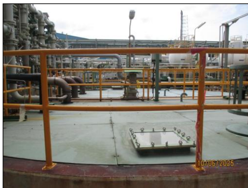
รูปที่ 3-4 ถังปรับสภาพน้ำ (Neutralization Tank)
