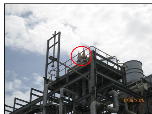
รูปที่ 3-43 Pressure Relief Valve
