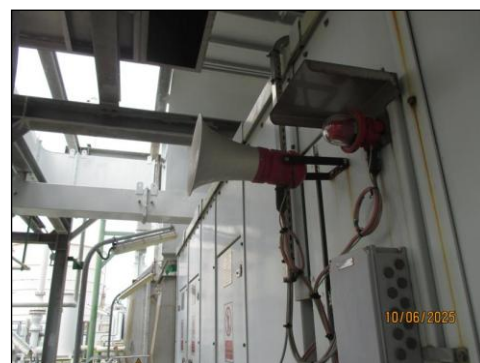
รูปที่ 3-26 Acoustic Alarm System
