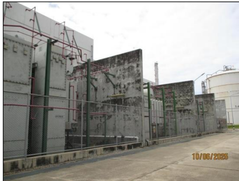
รูปที่ 3-21 พนังกันไฟระหว่างหม้อแปลงไฟฟ้าแต่ละชุด
