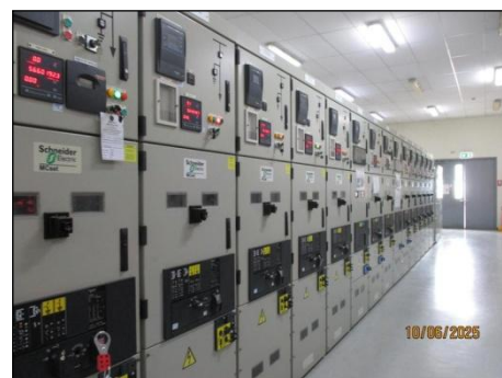
รูปที่ 3-19 ระบบ Remote Isolation
