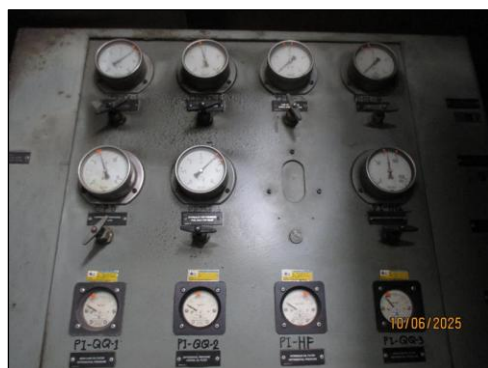
รูปที่ 3-42 ระบบ Pressure Monitoring
