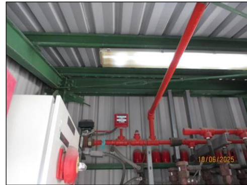
รูปที่ 3-39 Solenoid Valve CO 2
