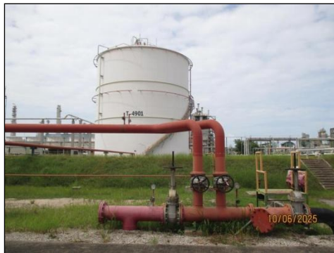
รูปที่ 3-23 ระบบเชื่อมต่อระดับเพลิงของหน่วยผลิตไฟฟ้า EPS และโรงผลิตสารโอเลฟินส์ สาขานนไอ-หนึ่ง
